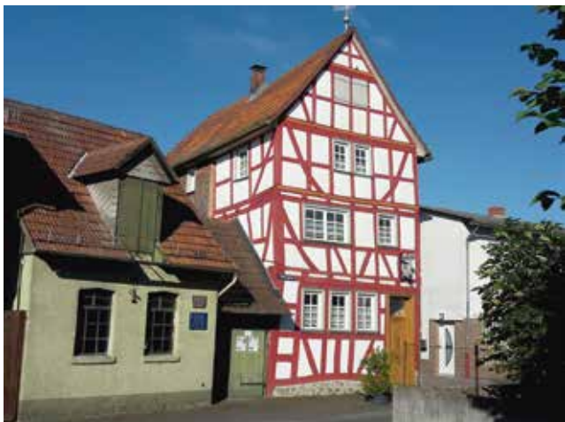
Alte Schmiede und Haus der Zünfte
