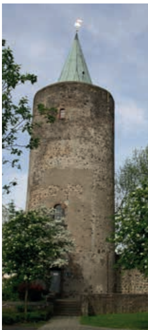
L'entrée de la Tour des Voleurs
