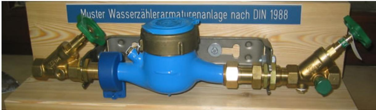
**Schema einer korrekt installierten Wasserzähler-Anlage nach DIN 1988:**
